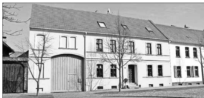
Ackerbürgerhof mit haustypischem großen Tordurchfahrt, Erdmannsdorfstr. 211
