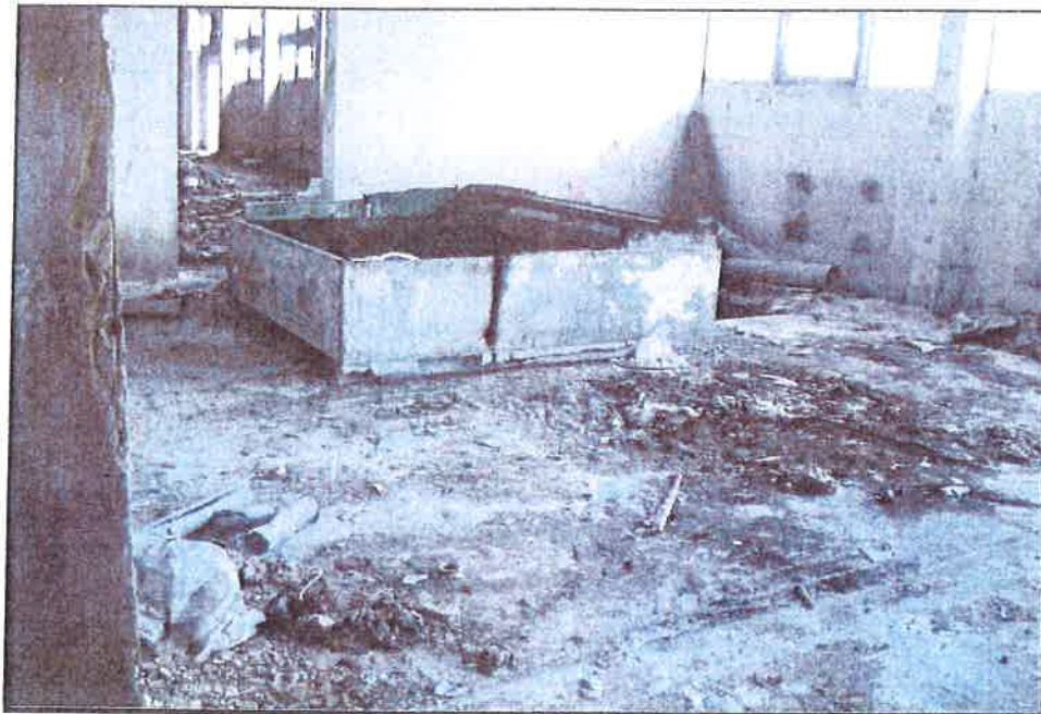
Foto 15: ALVF 13, Gebäude 37, Reste Farbgebung
