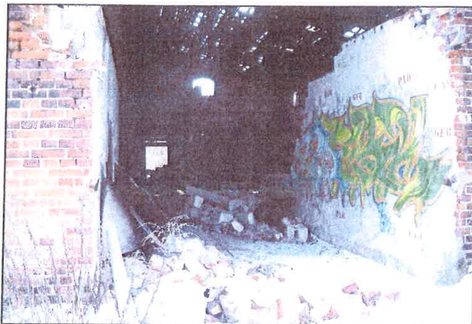
Foto 6: Blick in Gebäude 12, darunter ALVF 5 im Keller (Gebäude 12a)
