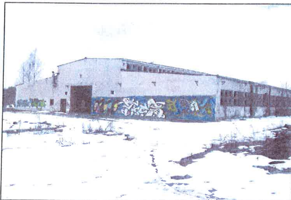
Foto 14: ALVF 13, Gebäude 37 und 37a
