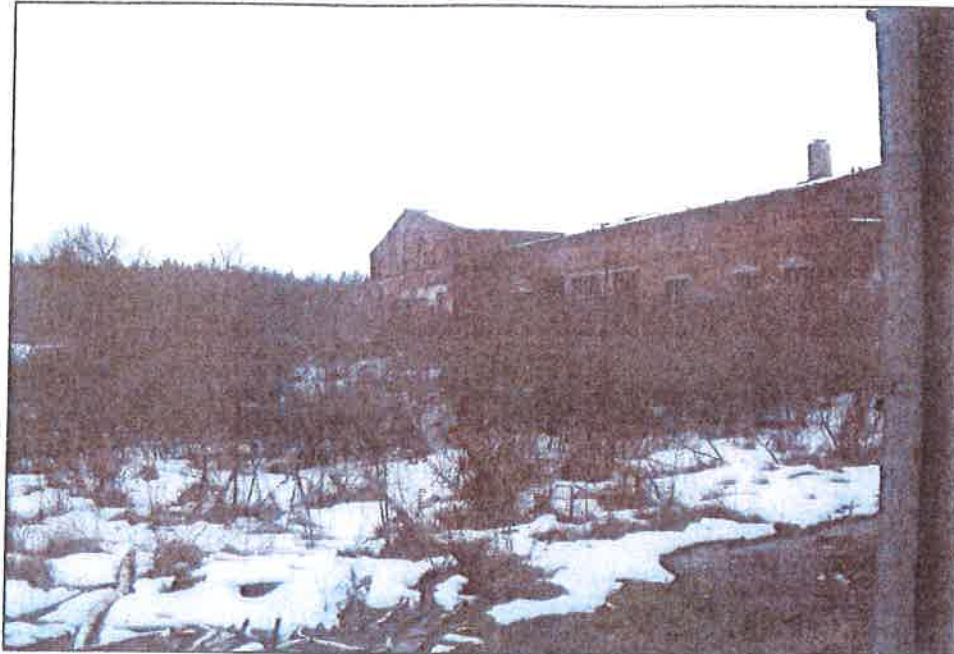
Foto 5: ALVF 3, vermutete Altablagerung um Gebäude 12
