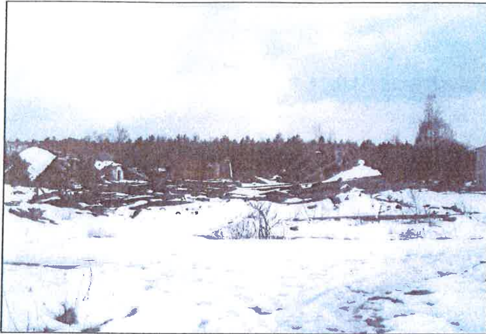
Foto 1: ALVF 1, Reste Gebäude 3 und 3a
