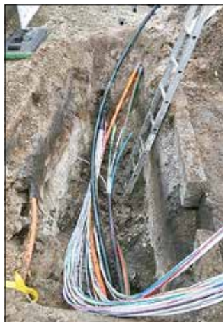
Beispiel für den Ausbau des Glasfasernetzes
