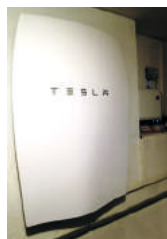
Abb. 12-18 Stromspeicher für PV
