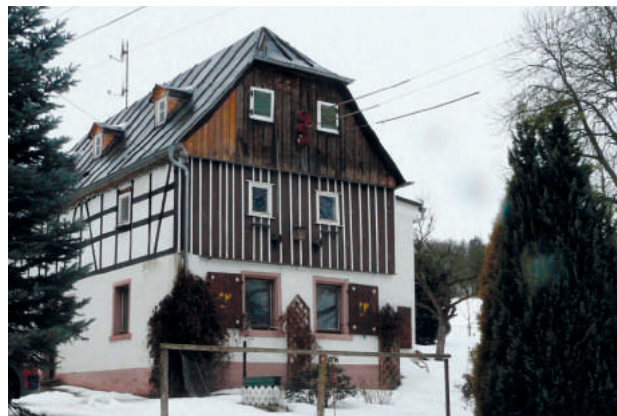
Abb. 12-9 Gebäude vor der Sanierungsmaßnahme
