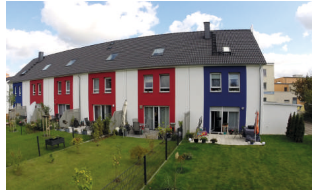
Abb. 1-1 Beispiel für Neubau
