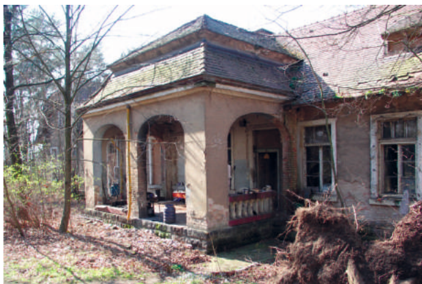
Abb. 12-6 Gebäude vor der Sanierung
