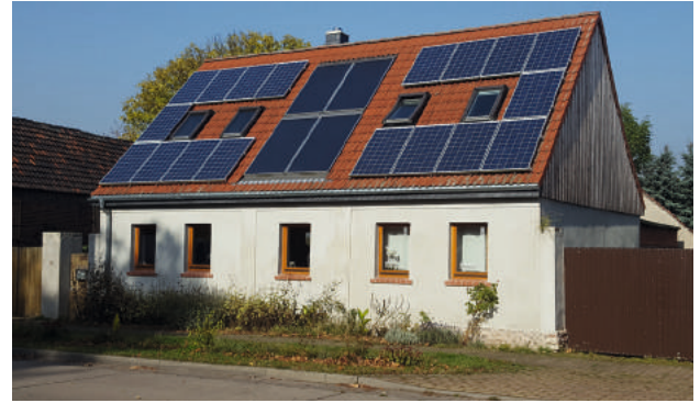
Abb. 2-5 Beispiel energieeffizient saniertes Haus
