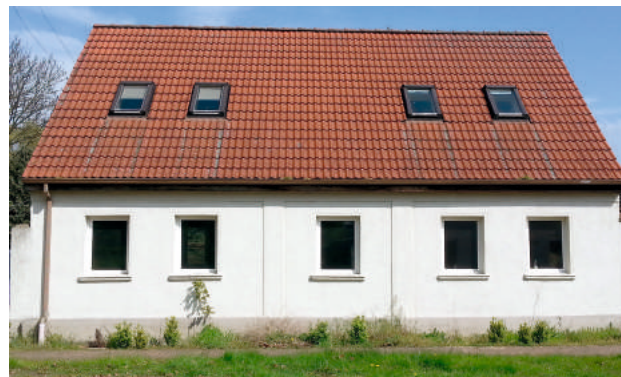
Abb. 12-15 Gebäude vor der Sanierung
