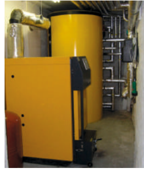
Abb. 12-8 Pelletkessel Heizung
