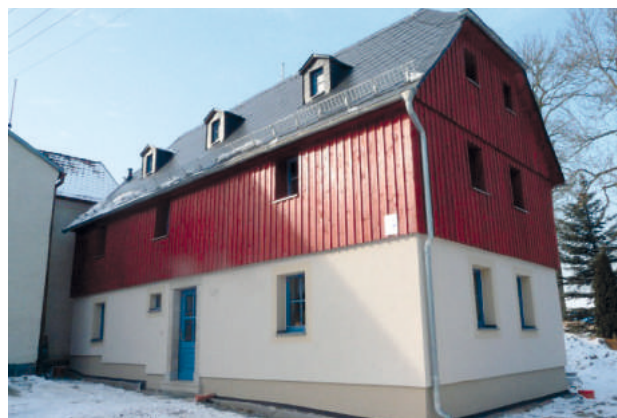
Abb. 12-10 Gebäude nach der Sanierungsmaßnahme
