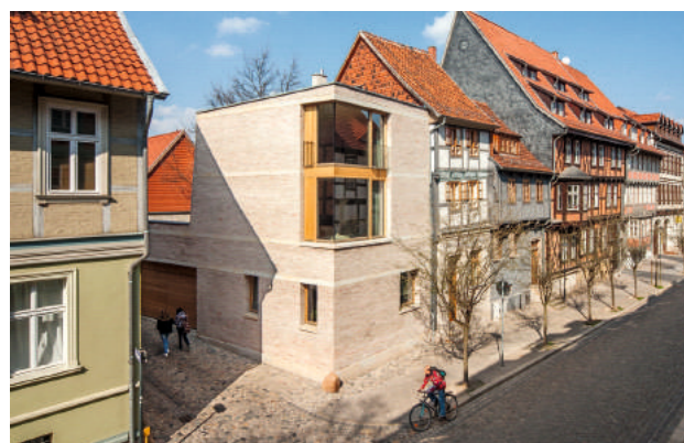
Abb. 12-25 Gebäude nach der Sanierung mit neuem Anbau
