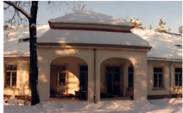
Abb. 12-7 Gebäude nach der Sanierungsmaßnahme
