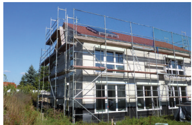
Abb. 12-2 Gebäude während der Bauphase
