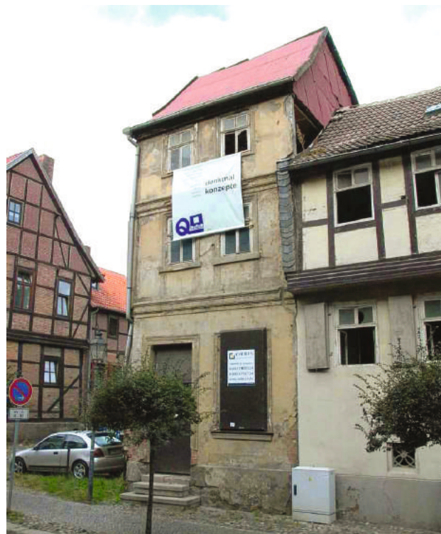
Abb. 12-24 Gebäude vor der Sanierung
