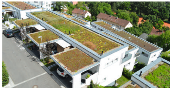
Abb. 7-70 Wohnsiedlung mit Dachbegrünung
