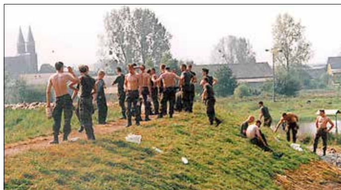
* Füllen von Sandsäcken im Kraftwerk Vockerode
