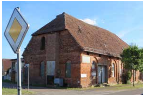
Abb. Baufällige ehemalige Brauerei
