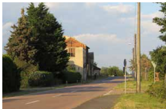
Abb. Ortseingang Gohrau mit leerer ehemaliger Mühle
