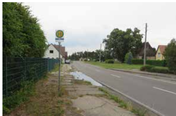
Abb. Zustand Bushaltestelle nördlicher Ortseingang
