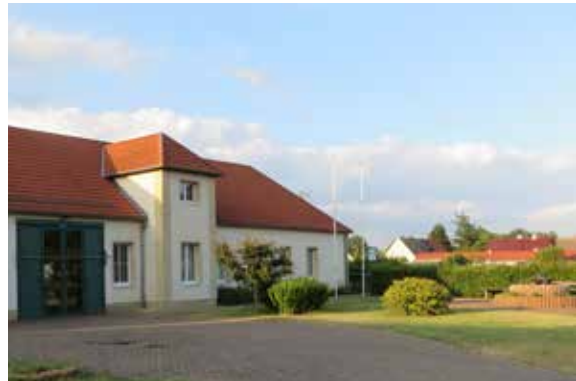
Abb. Aufwendig gepflegte Flächen vor Feuerwehr
