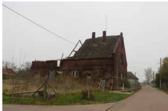
Abb. Baufälliges Leerstandsobjekt in Münsterberg
