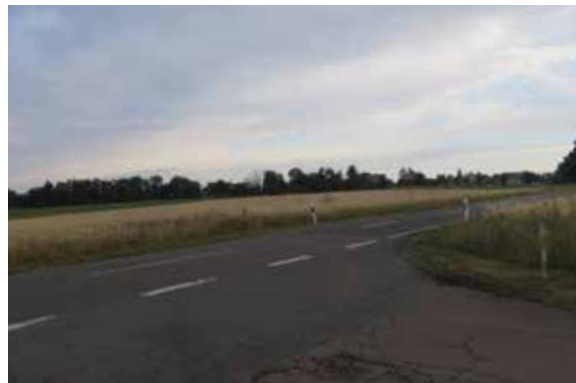
Abb. Straßenschäden und fehlender Radweg an Kreuzung
