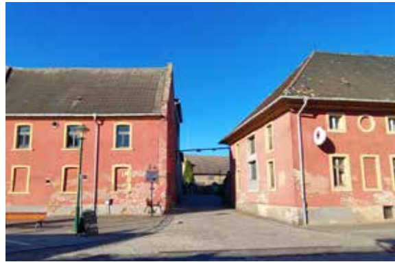
Abb. Leerstehende ehemalige Brauerei
