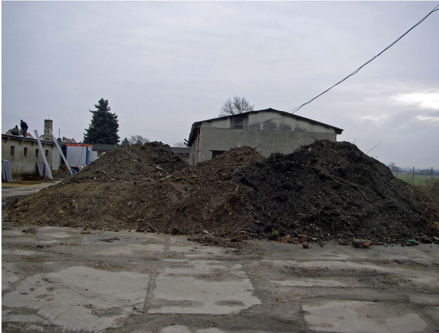
Abb. 12: Beispiel für abgelagerte Erdstoffe, hier am Nordgiebel der Lagerhalle (Baufeld 3). Die Erdstoffe sind Aushubmaterialien, die wieder verwendet werden. (Foto RIK: P131216-045)
