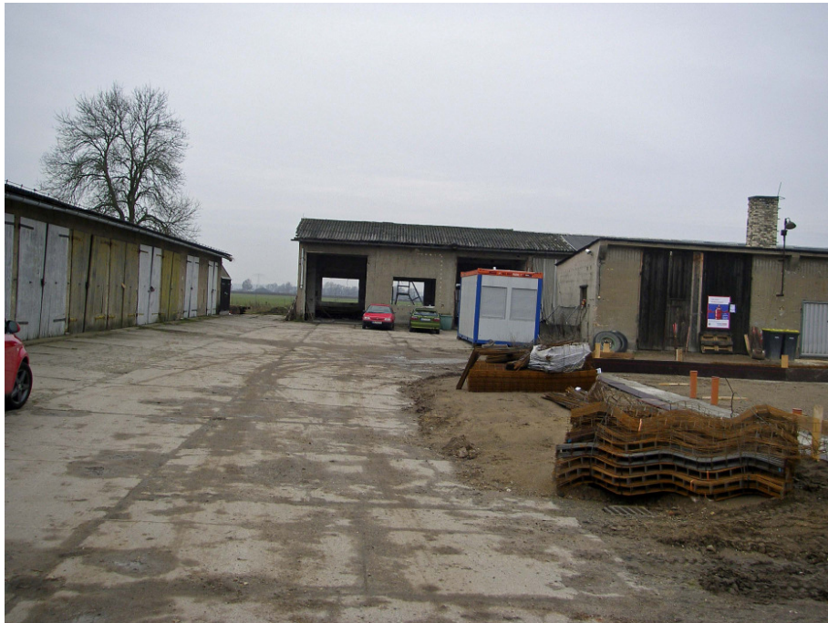
Abb. 10: Beispiel für die Befestigung der Verkehrswege mit Straßenbeton. (Foto RIK: P131216-008.JPG)
