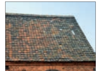
Einfache Biberschwanzdeckung auf einer Scheune des 19. Jahrhunderts
