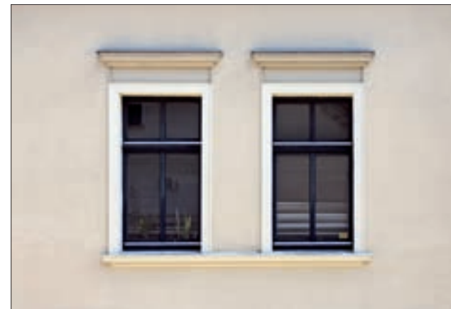
Spätklassizistisches Fenster mit durchlaufender Sohlbank der historischen Bebauung
