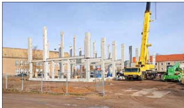
Rohbau des Gemeindezentrums im OT Vockerode
